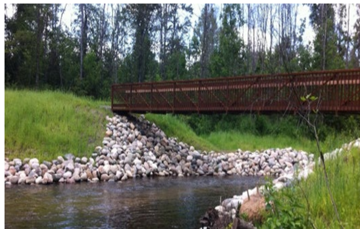
Après l'enlèvement du barrage de Buhl. Source : A. Ania
