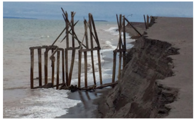
Restants du canal original qui transportait des sables submergés dans le lac Supérieur. Source : Steve Casey (retiré), Minnesota Department of Natural Resources.
