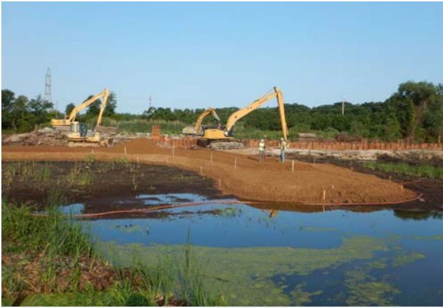
Des entrepreneurs terminent le travail d'assainissement des sédiments et commencent à préparer les terres humides. Source : USEPA.
