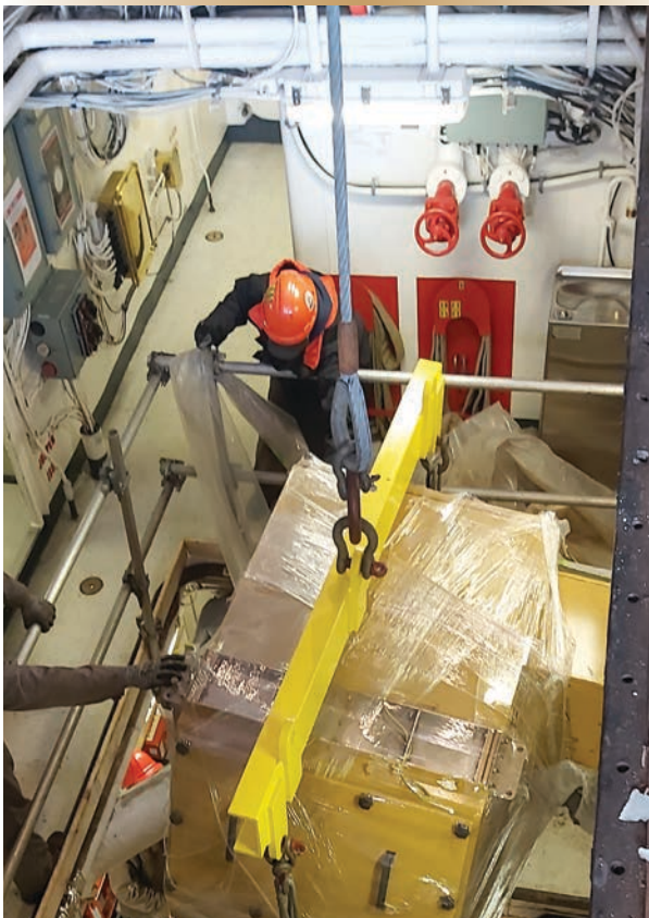
Figures 3a et 3b. Un nouveau groupe électrogène Hitzingier est déplacé dans le hangar du navire et abaissé dans la salle des machines auxiliaires arrière.
