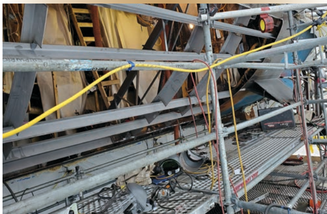
Figure 1. Échafaudages installés à l'intérieur de l'enclos protecteur contre les intempéries, avec le bordé latéral du navire et la section de la quille de roulis retirés.
