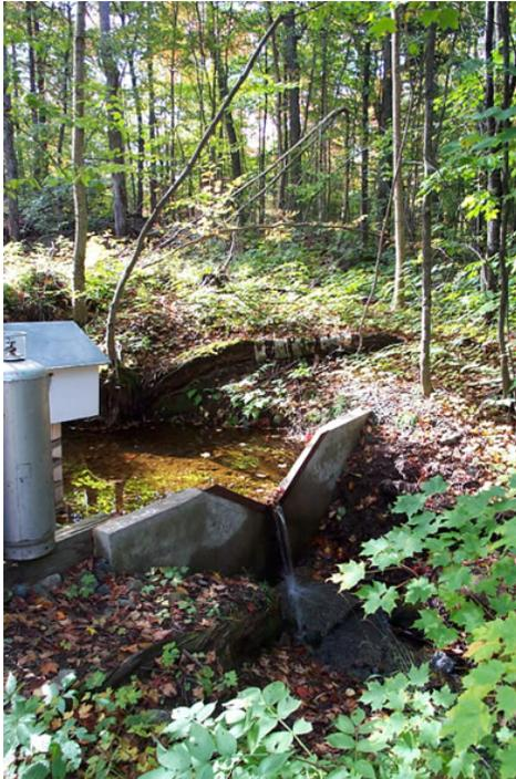
Déversoir à échancrure triangulaire installé dans le bassin des lacs Turkey aux fins de surveillance de l'écoulement fluvial et de la qualité de l'eau.
