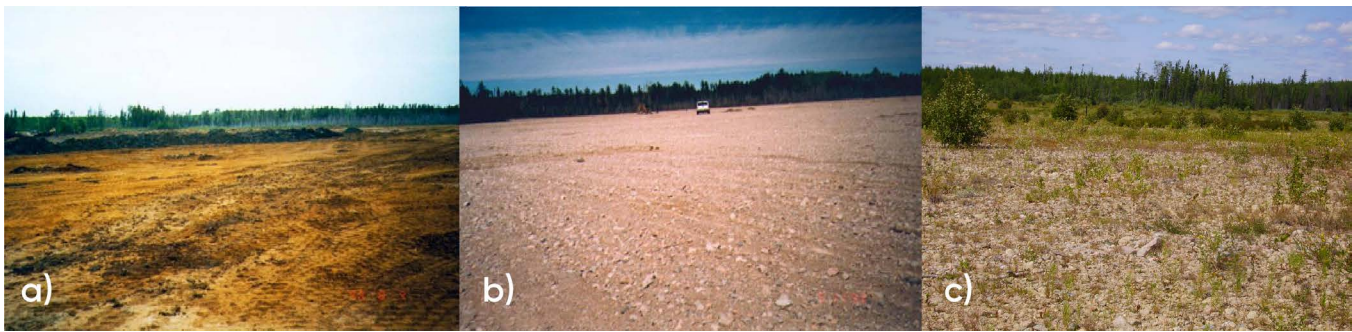
Figure 7.10 : Évolution du site minier de Lorraine, au Québec, restauré à l'aide d'une couverture avec effets de barrière capillaire. a) Avant la restauration, b) Après la restauration de 1998 et c) le site en 2007. Source : Adapté de Bussière et coll., 2009.
