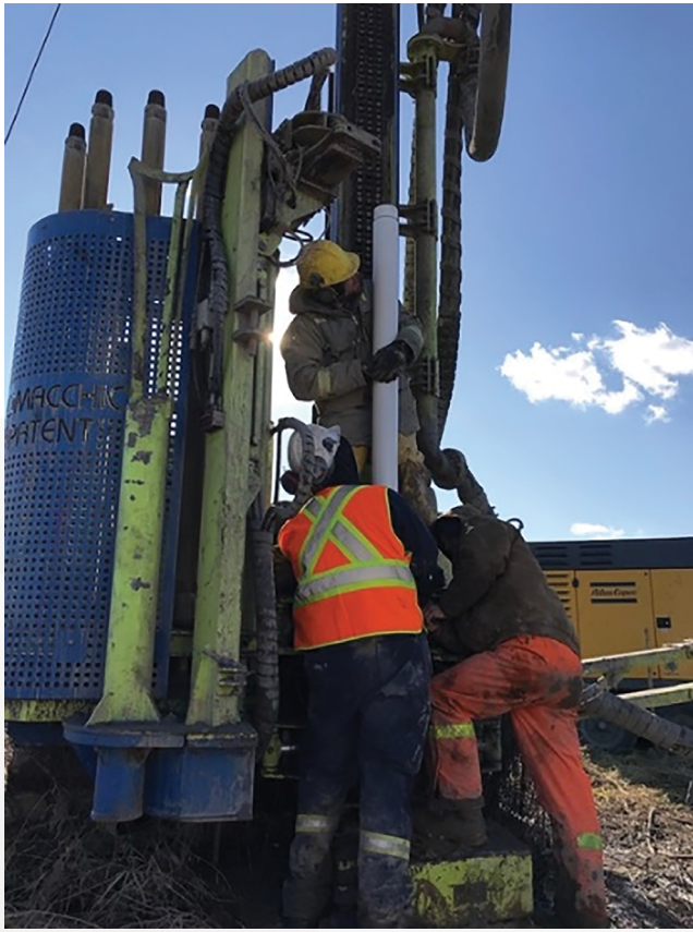
Figure 13. Installation d'un puits d'observation dans l'esker de Vars-Winchester, près de la ville d'Embrun (Ontario).
