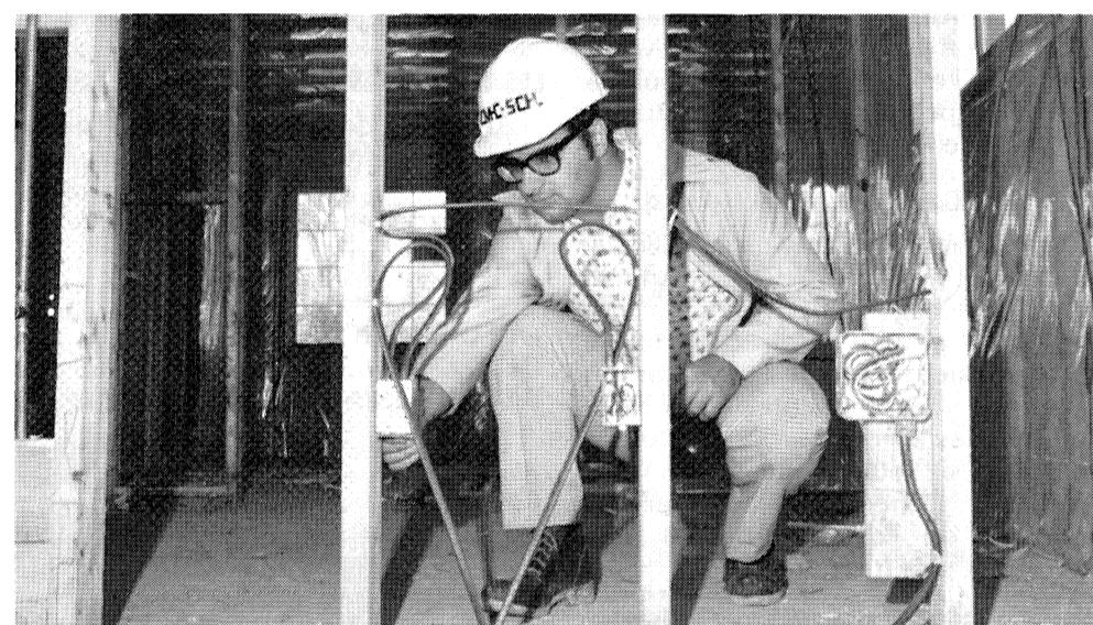
Tout comme la plomberie et parfois, certains conduits de chauffage, les fils électriques sont dissimu-lés dans les murs et relient interrupteurs, prises de courant et sorties électriques en un réseau parfois complexe. Le polyéthylène que l'on voit sur les murs extérieurs recouvre l'isolant thermique posé entre les poteaux et le protège de la vapeur d'eau venant de l'intérieur; on l'appelle pare-vapeur.
