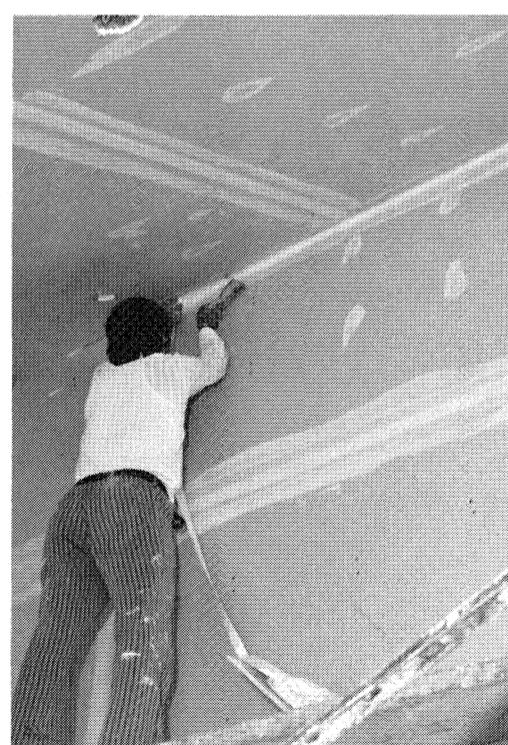
Pontage des joints entre les plaques de plâtre. Après avoir noyé un ruban perforé dans le ciment spécial, l'ouvrier recouvre le joint de deux autres couches de ciment. Le tout sera poncé après durcissement de la dernière couche, tout comme le ciment qui masque les vis de fixation.
