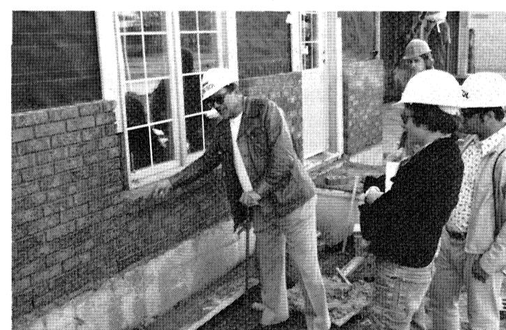
Détail de briquetage. L'appui d'une fenêtre est généralement constitué d'une pierre ou, comme ici, de briques posées sur chant, c'est-à-dire sur le côté et non à plat. Les briques posées dans le sens de l'épaisseur du mur se nomment boutisses, par opposition aux panneresses, dont l'axe est parallèle au mur.
