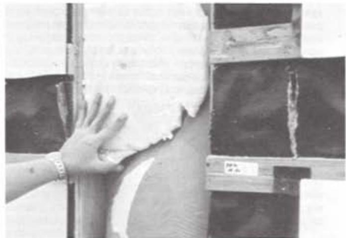
Exemple de mousse isolante mal soufflée qui s'est rétréci.
