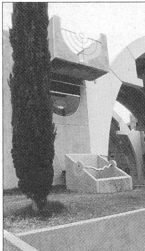
*La pluie - rare dans le désert - s'écoule du toit vers une citerne pour être utilisée.*
