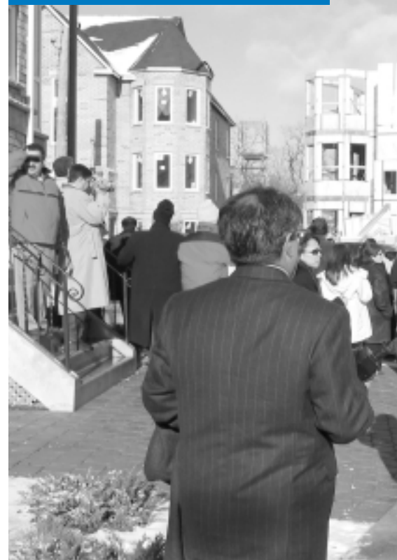
Visit to steel-frame construction site. Visite du chantier de construction d'un bâtiment à ossature d'acier.
