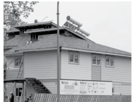
Construction site of Saanich Flex Plex. Chantier de construction des habitations multiples adaptables de Saanich.
