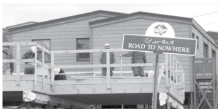
Le chantier du soleil de minuit a eu lieu les 20 et 21 juin, à Iqaluit, près de la fameuse rue « Road to Nowhere ». The Midnight Sun Build held June 20 - 21 in Iqaluit near the famous Road to Nowhere.
