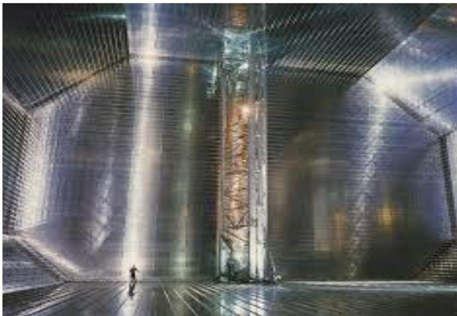
*À l'intérieur du réservoir à membrane d'un transporteur de GNL typique de 266 000 m<sup>3</sup>*
