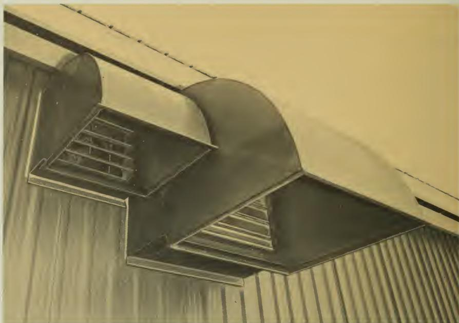
Figure 6. Les auvents placés au-dessus de l'ouverture des ventilateurs empêchent la pluie de pénétrer et réduisent les effets des vents contraires.
