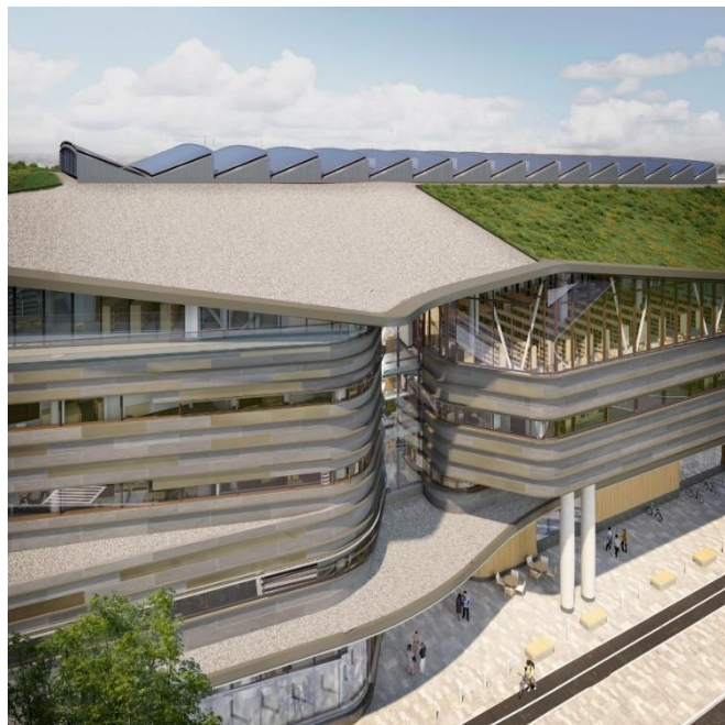
Figure 8 : Caractéristiques menant à la carboneutralité (toit vert et panneaux solaires).
