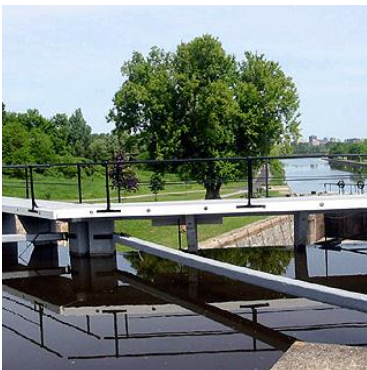
Écluses Hartwell sur le Canal Rideau © Google
