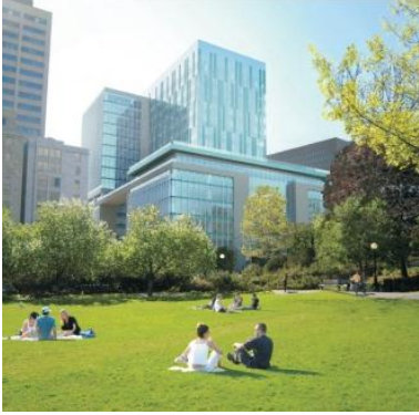
90 rue Elgin, Projet fédéral en cours de construction © Travaux publics et services gouvernementaux Canada (TPSGC)
