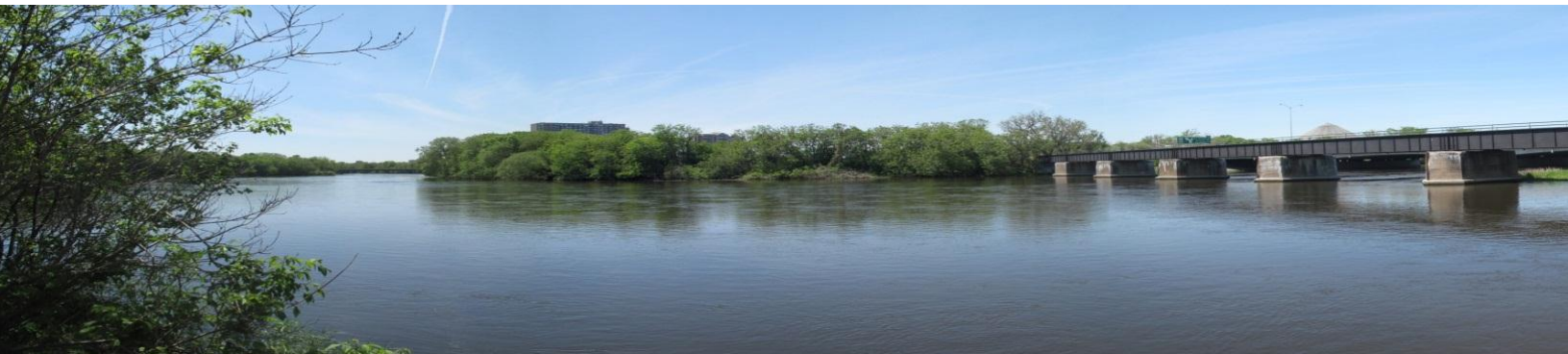
Rivière Rideau à proximité de la station Hurdman © CCN
