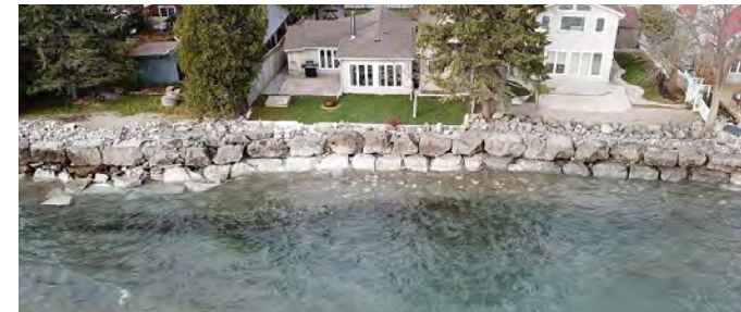
Le renforcement des rives par un enrochement réduit la résilience naturelle
