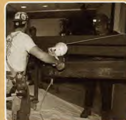
Introduction d'une poutre par la fenêtre du bureau du ministre.
