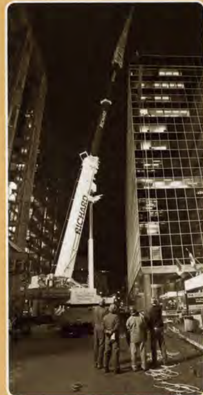
Ajout de poutres d'acier de renforcement au Centre des données d'Industrie Canada (CDIC).
