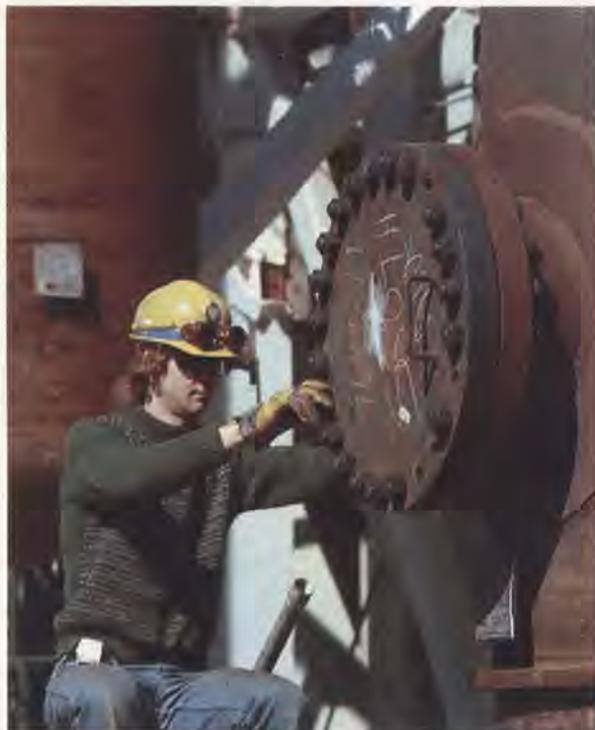
Mise en place d'un réservoir sous pression dans une usine d'exploitation de sables pétrolifères
