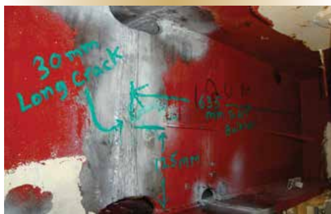
Figure 3. Fissure de 30 mm découverte sur la paroi d'une poutre à bord du NCSM Ville de Québec (FFH-332). (Huang, 2021)
