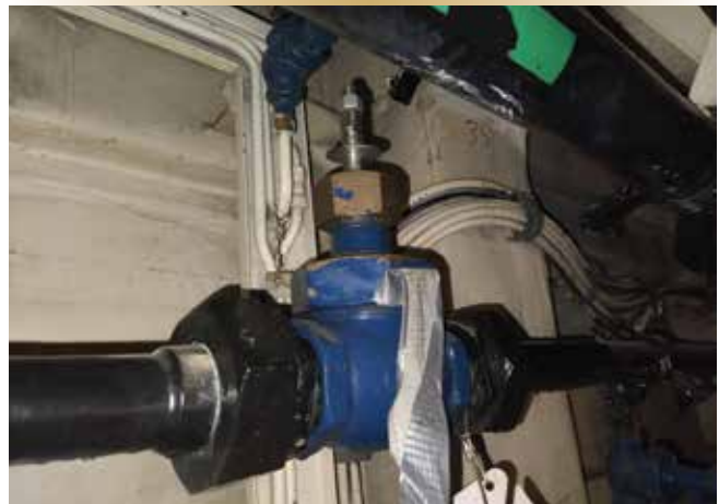
Figure 1. Clapet de non-retour à vis à bord d'une frégate de la classe Halifax .
