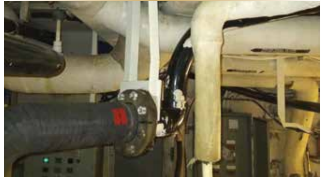
Figure 2. Alimentation et retour d'eau réfrigérée.
