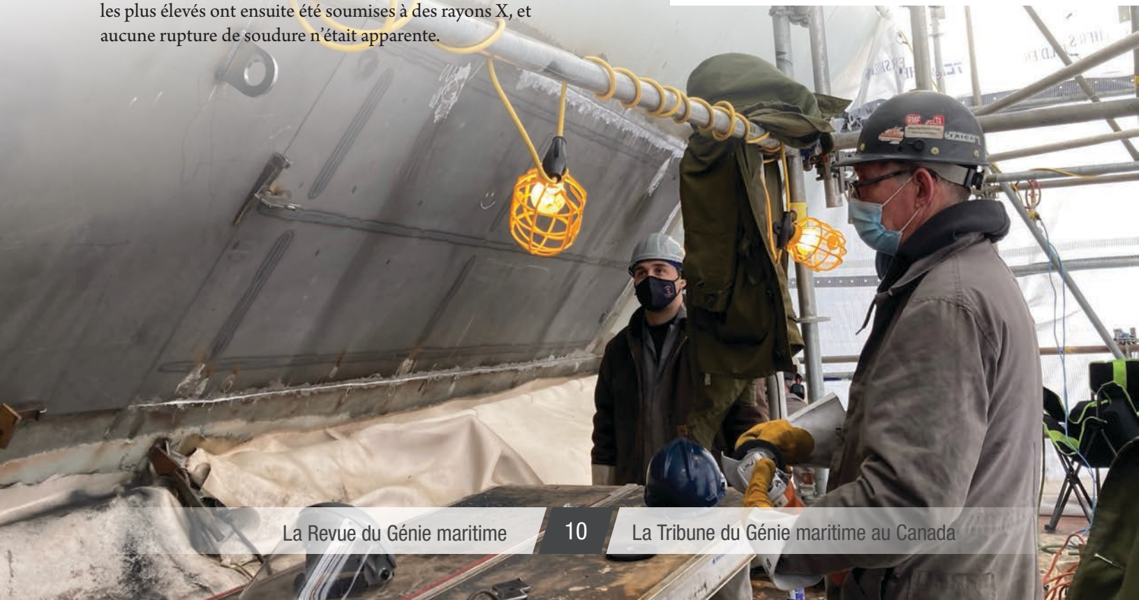
Figure 6. Les personnes de métier de l'IMF ont tenu les insertions de nouvelles plaques et les ont fixées fermement aux lisses et aux couples pour le soudage final.
