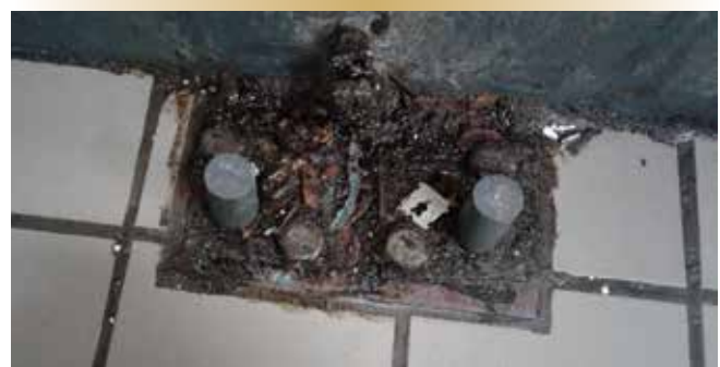
Figure 6. Raccord d'appareils de cuisine gravement corrodé.
