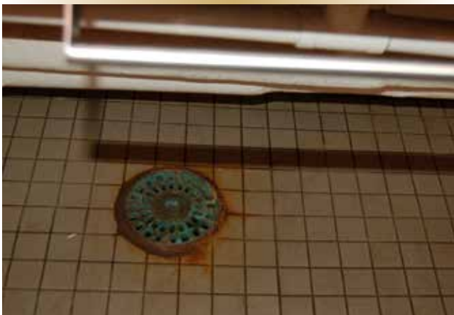
Figure 9. Le problème relatif à l'utilisation de métaux dissemblables de l'utilisation de métaux différents pour les interfaces de raccord.
