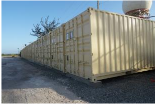
12 - Les nouveaux conteneurs maritimes sont placés sur des blocs de béton dans la nouvelle zone d'entreposage Photo Par: Maj Pierre-Alexandre Goulet
