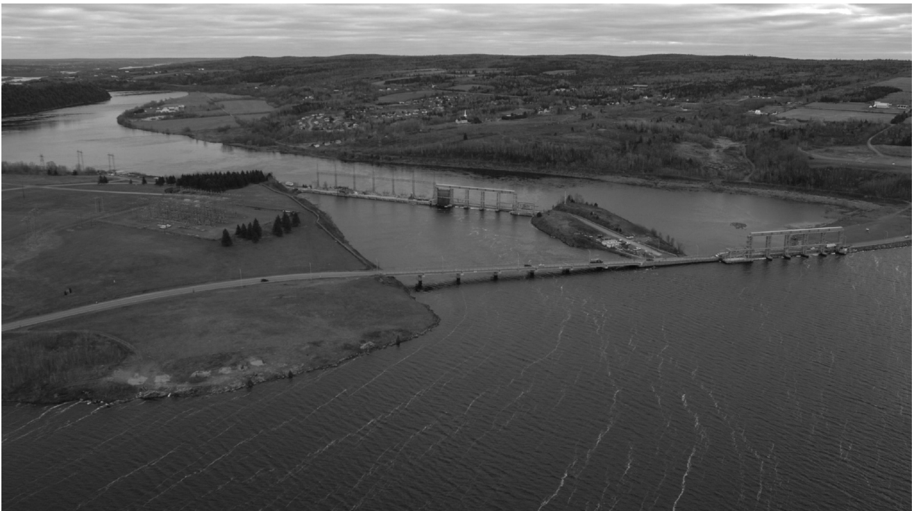
BARRAGE DE MACTAQUAC (VUE DE L'OUEST) (2006)
