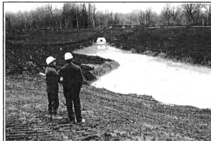
Figure 16 Bassin de retenue d'eaux pluviales à Ajax, en Ontario. Le bassin est situé dans une vallée donnant sur une région écologiquement sensible. Photo prise pendant la construction.
