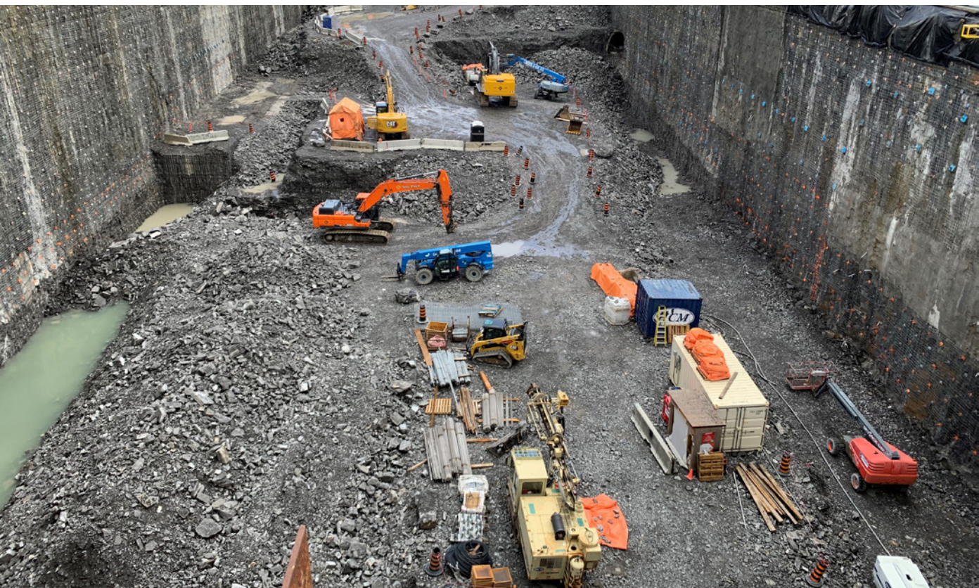
Travaux d'excavation à la Cité parlementaire
