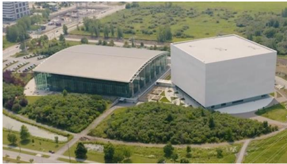
Le Centre de préservation et l'Édifice d'entreposage et de préservation de Bibliothèque et Archives Canada sis respectivement aux 625 et 635, boulevard du Carrefour, à Gatineau, au Québec.
