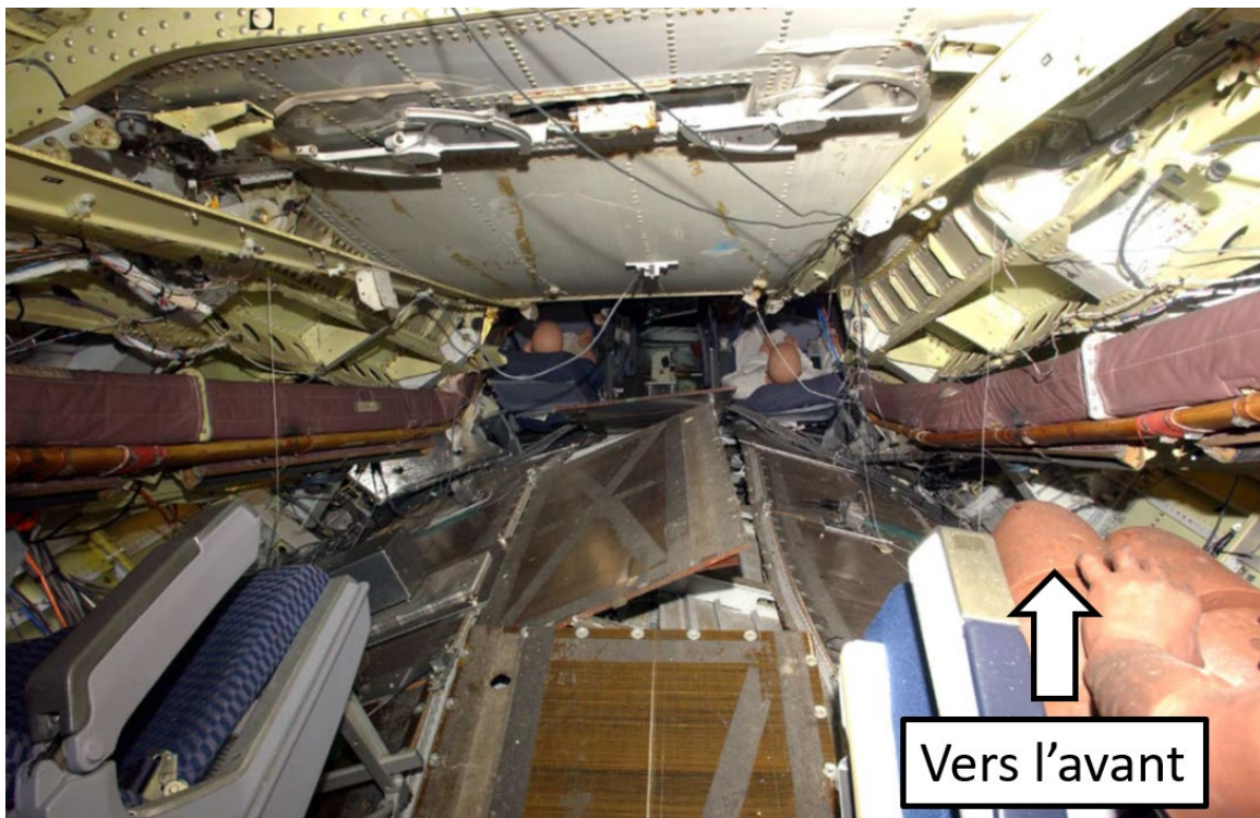
Figure 20. Photo de l'espace habitable (permettant la survie) réduit dans la partie centrale de la cabine par suite de l'affaissement de la voilure et de l'intrusion de la structure du train d'atterrissage principal au cours de l'essai de chute en 2006 (Source : Federal Aviation Administration des États-Unis, avec annotations du BST)
