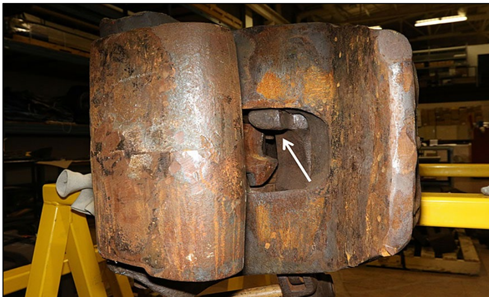
Figure 17. Tige de l'articulation Z du lève-verrou d'attelage coincée dans le trou du verrou
