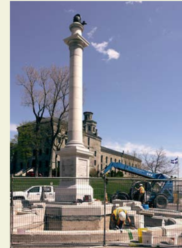
Travaux de restauration du monument Wolfe
