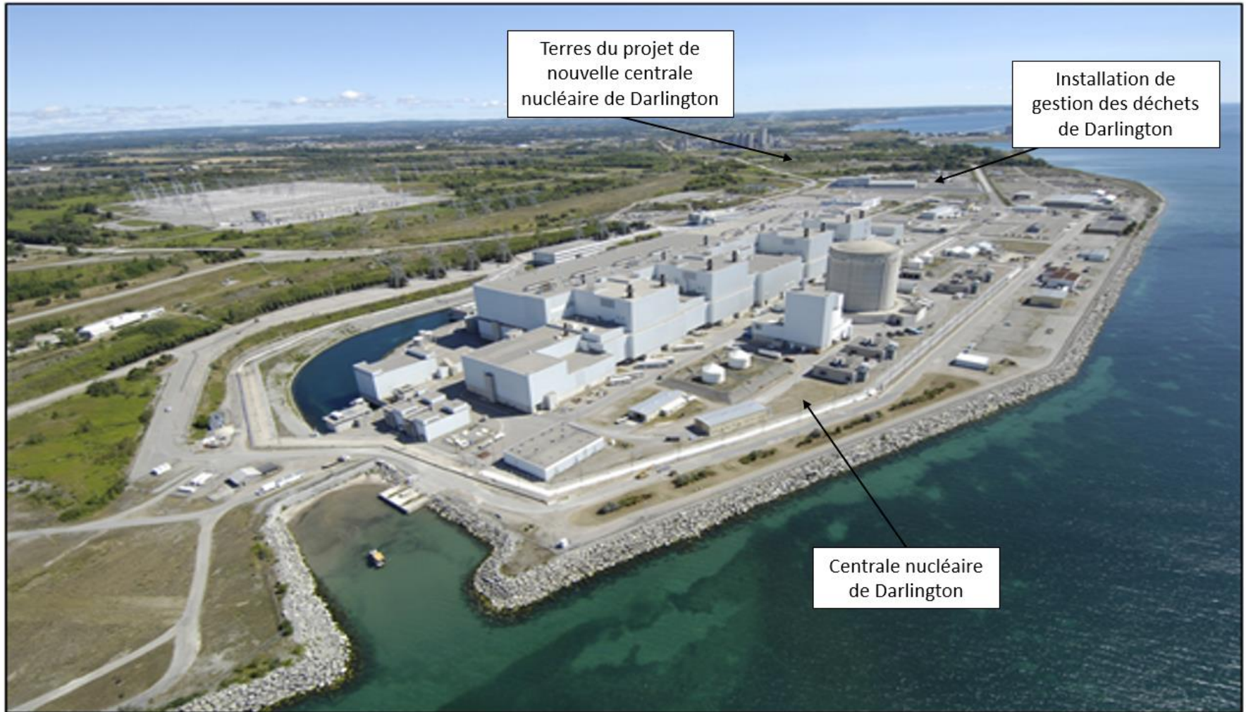
Figure 1.3 : Vue aérienne du complexe nucléaire de Darlington
