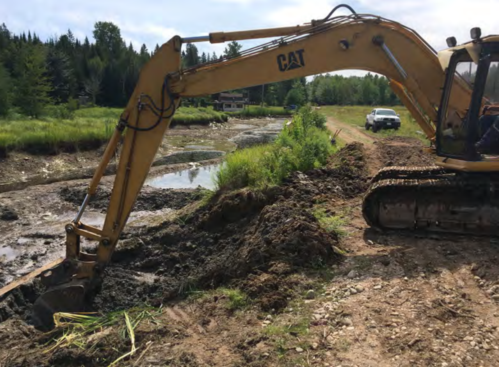
Excavatrice au marais Hazlett's, Nouveau-Brunswick. Canards Illimités Canada
