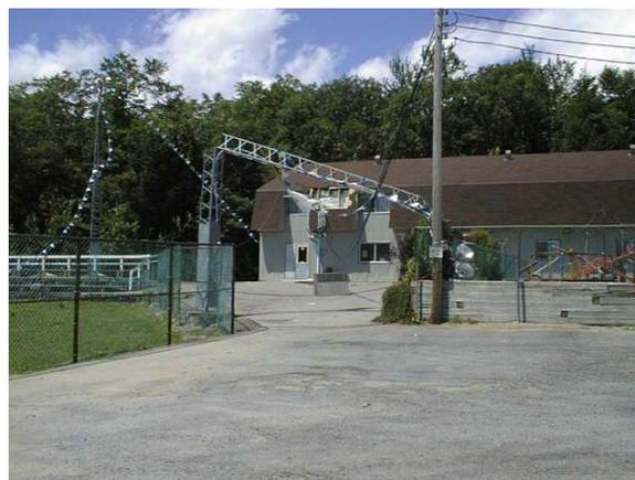
**Figure 16: Sur le Chemin de la Dame (Lac Quinn), un des multiples arbres déracinés par le vent et le poteau d'éclairage plié dans un parc de balle. À remarquer, un petit bout de toit envolé sur le bâtiment de la photo de droite.**
