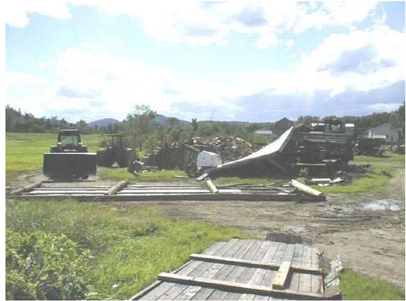
**Figure 11:** Tôle roulée par le vent sur le toit d'une remise juste à côté de la grange et abris pour le bois démoli.
