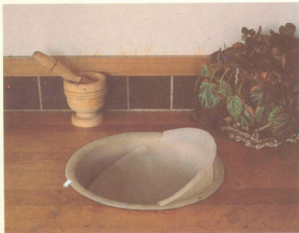
A la cuisine, les déchets sont déposés dans un orifice ménagé dans le comptoir, tombent au sous-sol dans le réservoir aérobique en fibre de verre.
