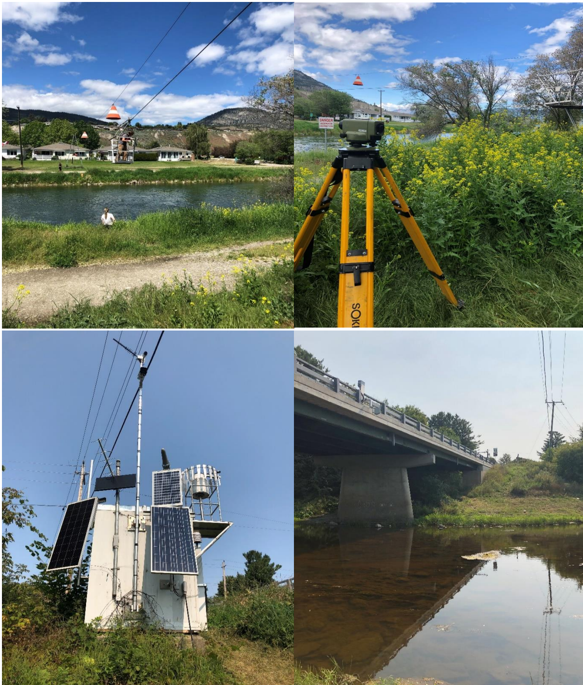
Figure 4. Rivière Castor, radars ancrés sur le pont et des balises de rive (Russell, Ont.)
