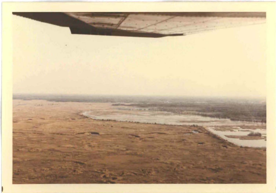
Photo 12. Vue aérienne des aménagements pour la sauvagine (digue et route d'observation) au parc Lester MacNamara. A l'avant plan, marécages bordant la rivière Tuckahoe et à l'arrière plan, forêt de pins et de chênes typiques au New Jersey.
