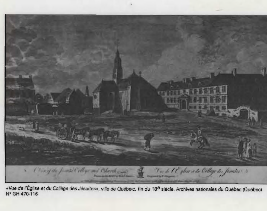
Vue de l'église et du Collège des Jésuites, ville de Québec, fin du 18e siècle. Archives nationales du Québec Québec N° 01 401 116
