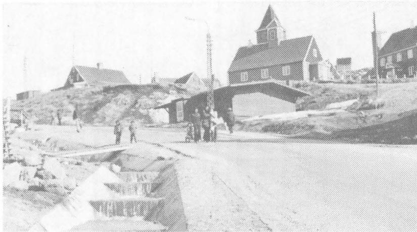
Figure 17 Fossé de captage des eaux de ruissellement enjambé par un passage
