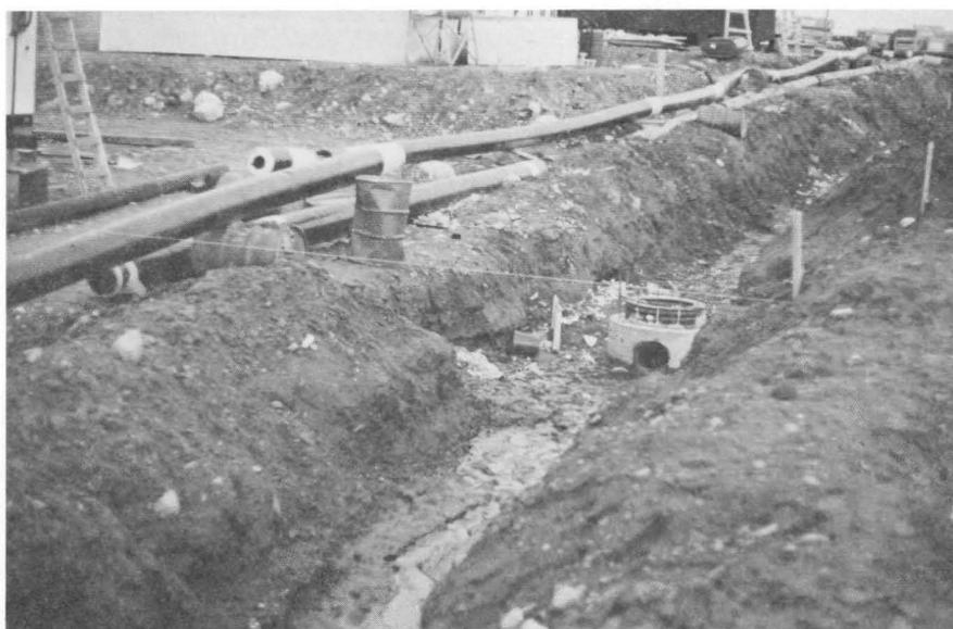
Photographie 17 Premier réseau de canalisations enfouies à faible profondeur et isolées séparément, Rankin Inlet, 1975
