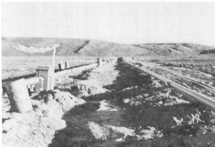
Figure 18 En 1978, un nouveau système de distribution d'eau a été mis en service à la Station Alert sur l'île Ellesmere. On a utilisé des canalisations SCLAIRCOR pour construire la conduite d'alimentation en eau de 8 200 pi qui alimente la nouvelle station, et pour relier la station à la base. Tous les tuyaux étaient protégés par une épaisseur d'isolant de 3 po, une gaine en acier galvanisé et un câble chauffant.
