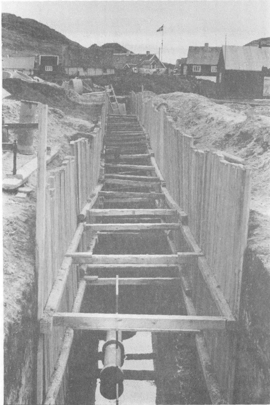
Figure 14 Construction d'un corridor d'égout
