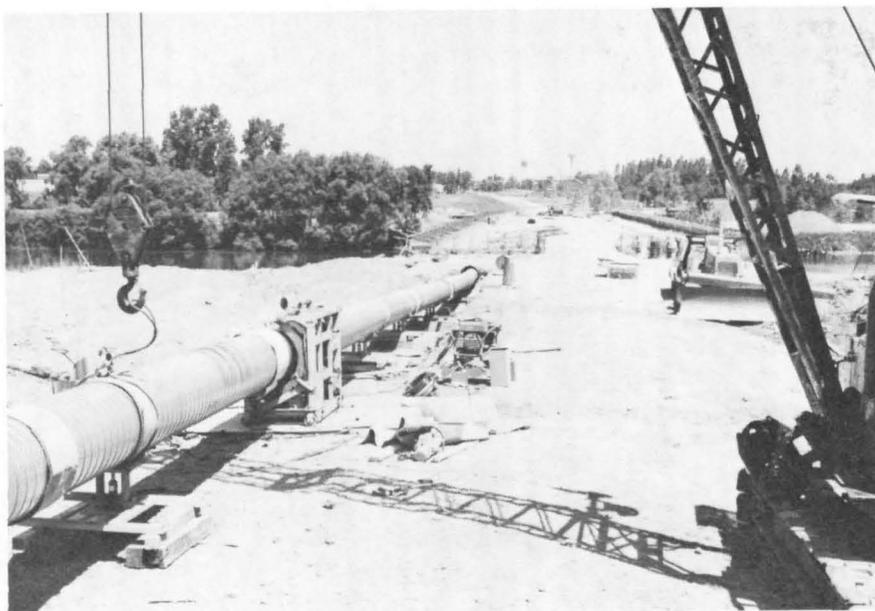
Une canalisation principale SCLAIR-COR de 20 po est suspendue sous le nouveau pont de la Welland River à Niagara Falls. On a utilisé une gaine isolante en acier de 2 po, ainsi qu'un système de deux câbles chauffants. On a joint en continu les 620 pi de tuyaux, puis on a poussé et tiré la canalisation au moyen de rouleaux pour la faire passer dans un conduit, sous le pont.
