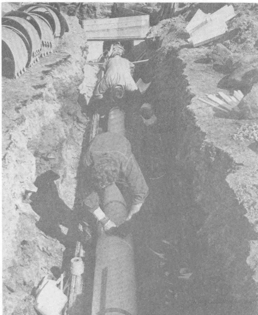
Figure 8 Pose d'une canalisation souterraine de distribution d'eau
