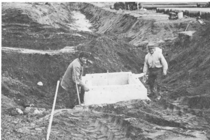
Photographie 18 Regard de service en béton préfabriqué, Frobisher Bay, 1976
