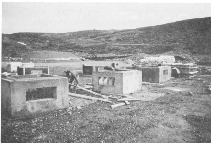
Photographie 25 Sections de regard de visite en béton préfabriqué
