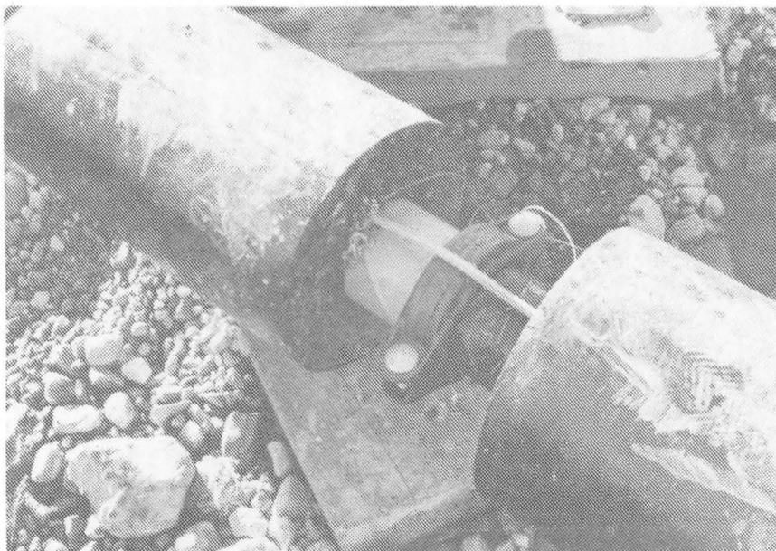
Figure 9 Raccordement d'une canalisation d'eau, isolée et équipée d'un câble chauffant
