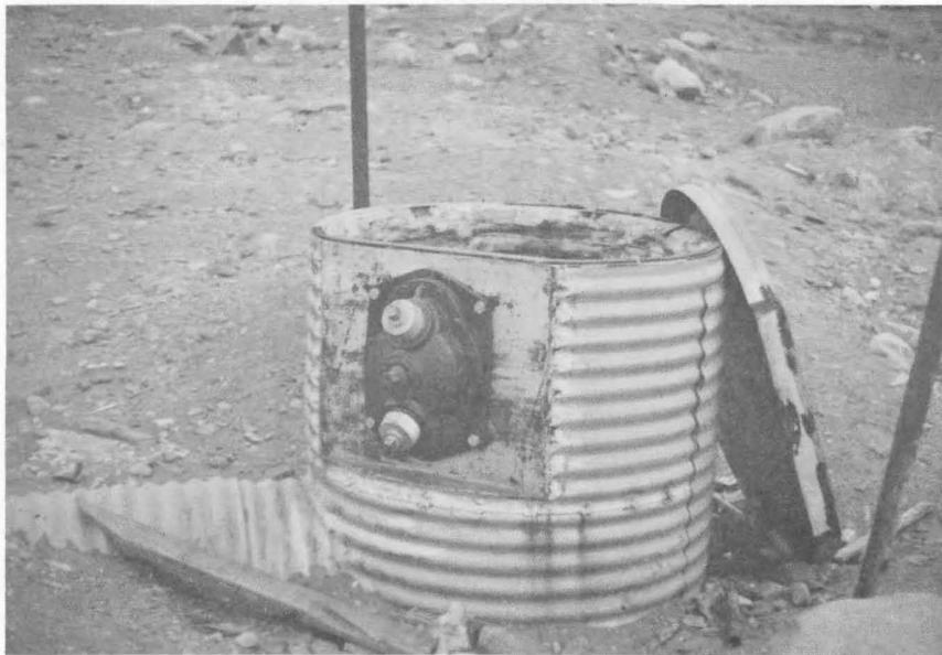
Photographie 10 Regard de service et prise d'eau avec raccord à deux voies
