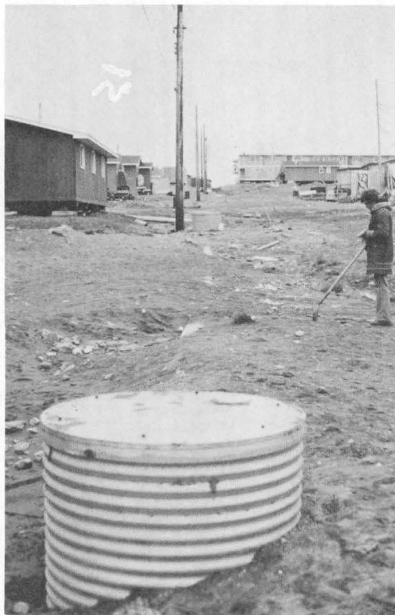
Photographie 13 Utilidor souterrain en métal ondulé, Rankin Inlet, 1974
