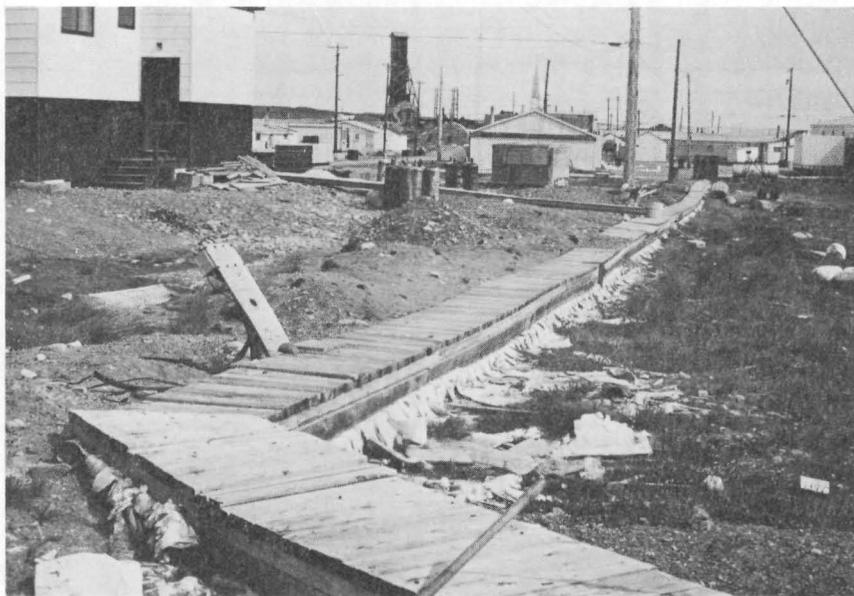
Photographie 7 Utilidor avec coffrage en bois, avant 1972
