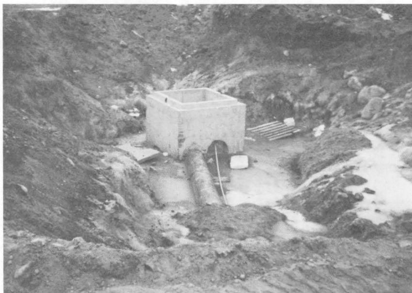
Photographie 19 Regard de service en béton préfabriqué, Frobisher Bay, 1976
