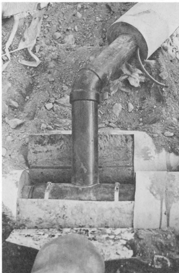
Photographie 5      Branchements particuliers par l'intermédiaire d'une conduite d'amenée
