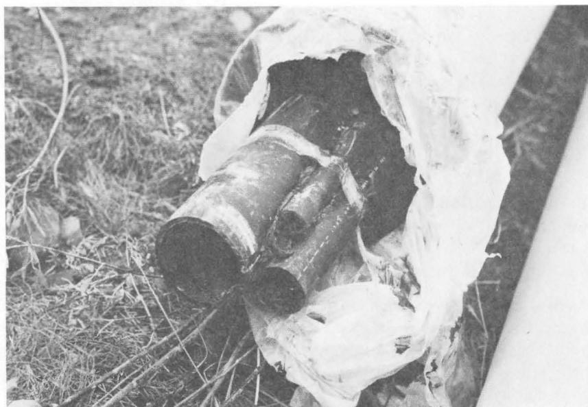
Photographie 20 Tube de dégel autour de conduites d'eau et d'égout, avec enveloppe isolante
