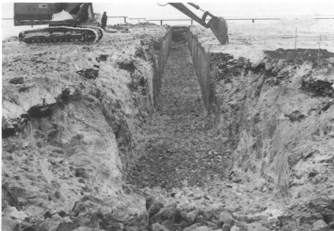
SECTION DE TRANCHÉE CREUSÉE À L'AIDE D'UNE ROCSAW ET PAR DYNAMITAGE
