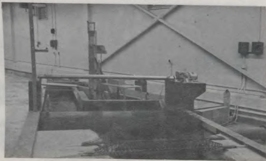
MECANISME DE REPRODUCTION DES MAREES - TIDAL MECHANISM
