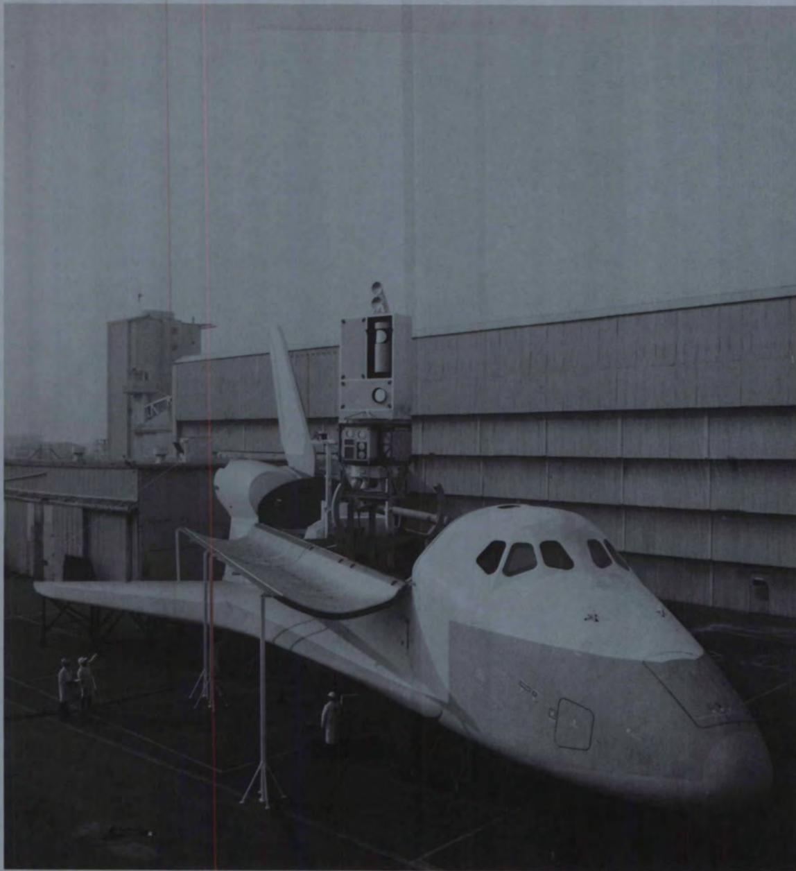
Au premier plan, maquette grandeur nature de la navette, chargée du mécanisme d'échange modulaire, et, à l'arrière-plan, le télémanipulateur. Bâtiment de la Rockwell International à Downey, Californie.
