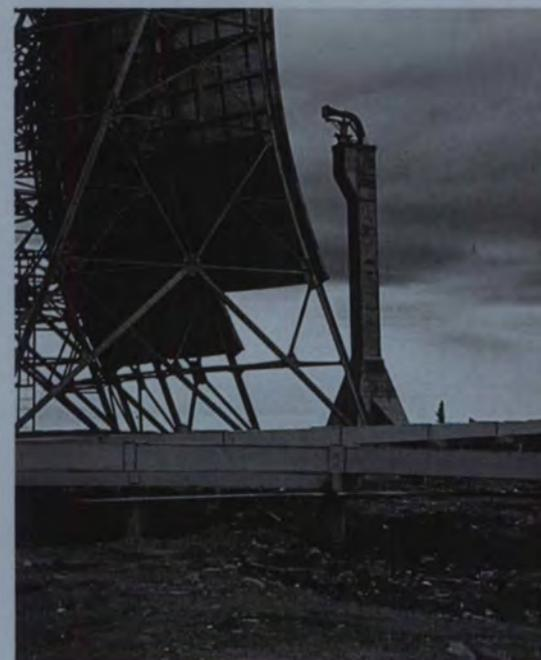
Andrew Antenna a construit les 12 dispositifs de guides d'ondes ainsi que les cornets d'alimentation à double polarisation, fonctionnant en 1 GHz, pour le premier système mondial de diffuseurs troposphériques, reliant Goose Bay, au Labrador, à Thulé, en Groenland.
