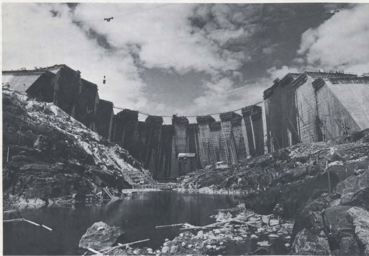
Au Québec l'énorme barrage de la Manicouagan est parmi les plus importants en existence.
