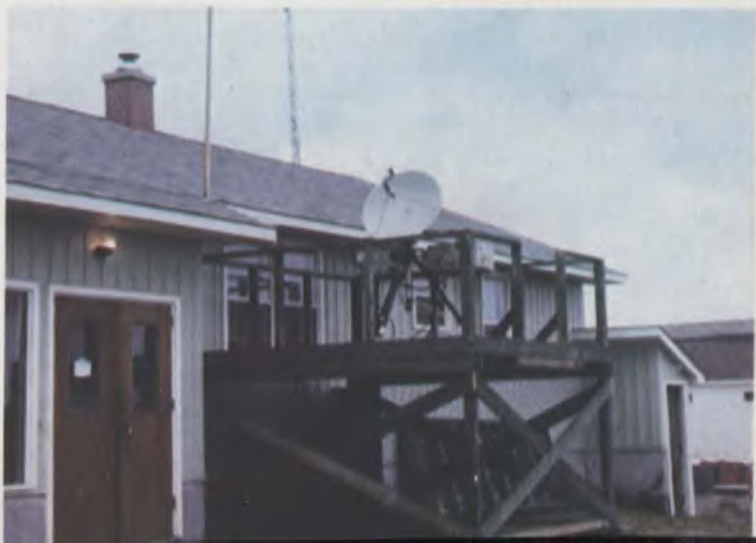
d) Terminal de téléphonie à Kashechewan (Ontario); diamètre de l'antenne, 1 m.
