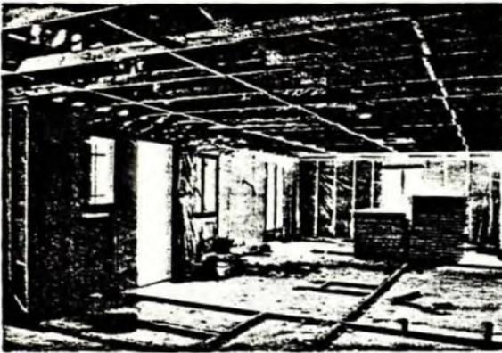
Photo 5 — Mise en place de l'isolation thermique et des canalisations électriques.
