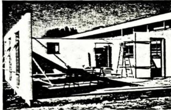
Photo 6 — Montage de maison par système de panneaux modulaires.
