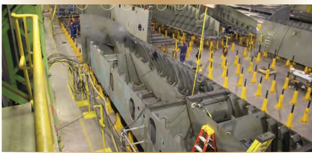
Assemblage de la structure principale.
