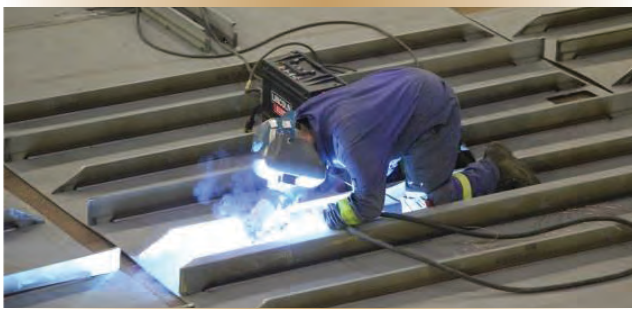
Soudure lors de l'assemblage de panneaux plats.
