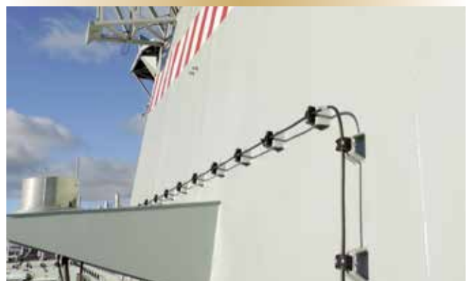
La DAS Rx Extension est acheminée sur la superstructure.
