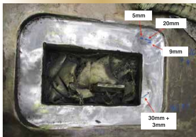
Figure 4a. Chemin de clef bâbord – Défauts décelés par contrôle magnétoscopique (6 mai 2022) à la suite de la réparation par accumulation de matériaux soudés.
