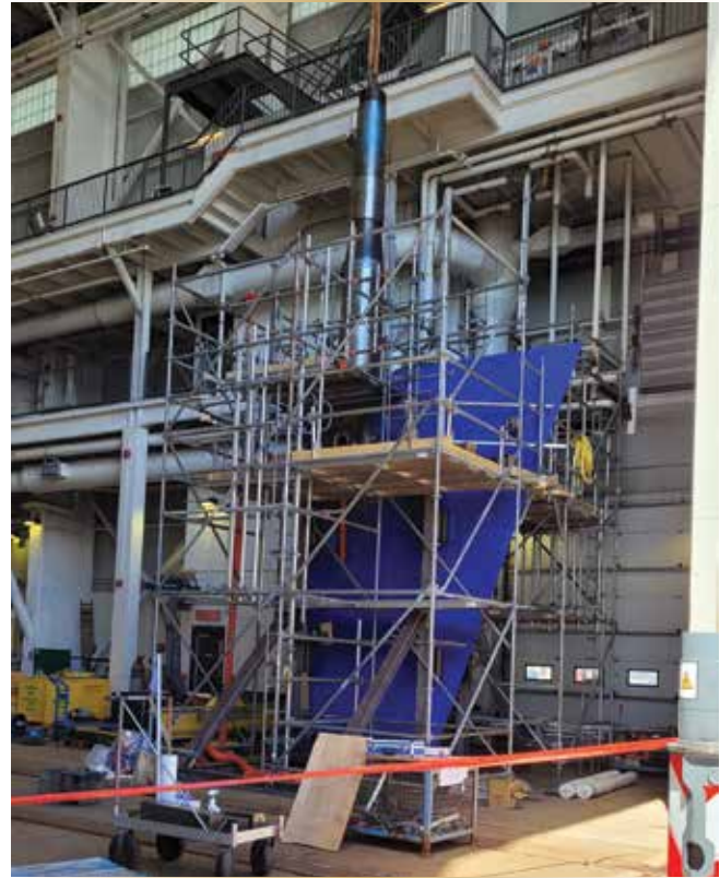
Figure 5. Gouvernail du Charlottetown à la verticale dans le gabarit.
