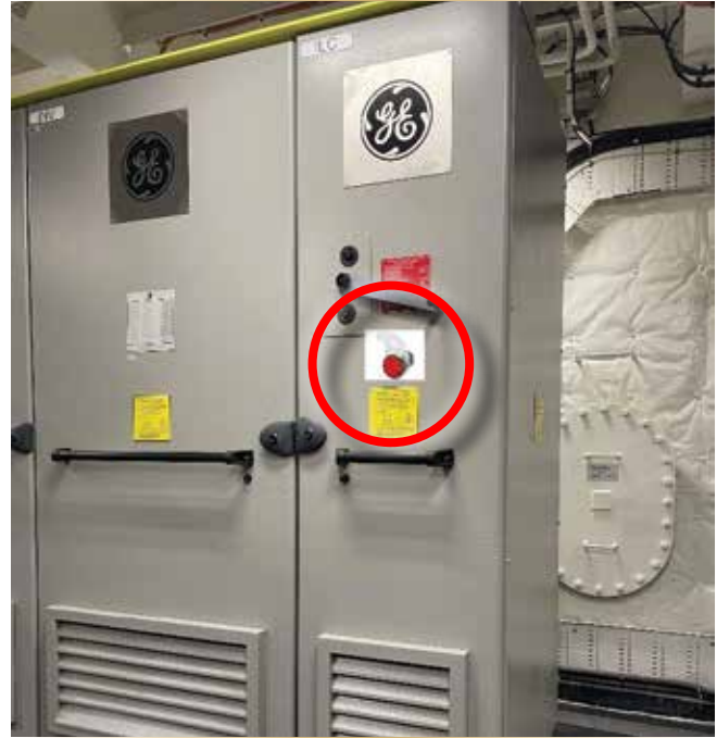
Figure 3. Une armoire munie d'une simulation de bouton-poussoir externe pour la réinitialisation logique.
