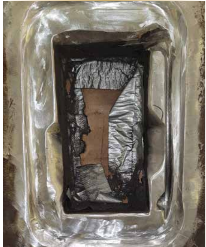
Figure 6. Réparation temporaire de l'ouverture du chemin de clef du Charlottetown et élimination des défauts.
