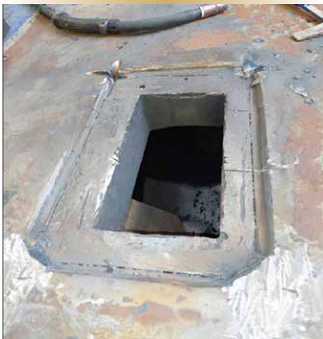
Figure 2. Ouverture du chemin de clef côté bâbord avec plaque de protection retirée pour accéder aux cales. Des rainures de la scie rotative sont visibles dans le moulage du moyeu de gouvernail.
