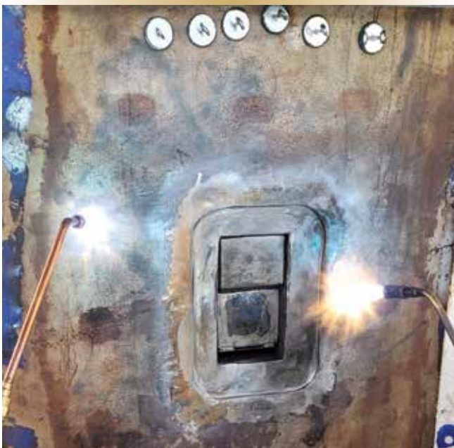
Figure 8. Préchauffer le moyeu du gouvernail du Charlottetown avant de souder les cales de fixation en place.
