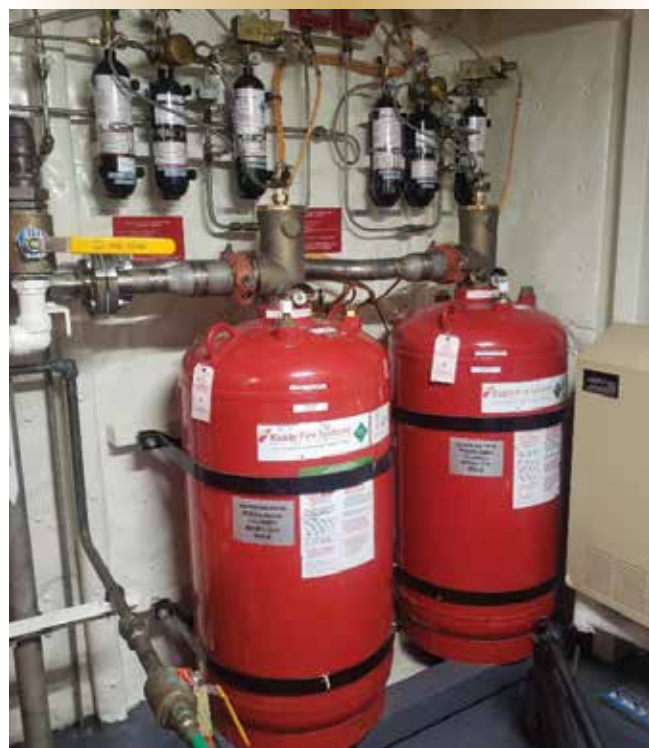
Figure 1. Système Novec 1230 sur le NCSM Harry DeWolf pour les espaces bâbord/tribord à basse tension.
