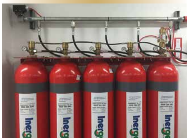
Figure 2. Une installation type d'IG-55, semblable à celle du halon 1301.
