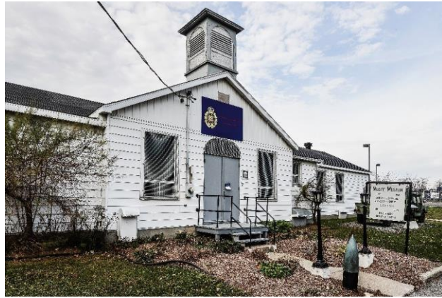
22 - Le MLFC alors qu'il occupait la bâtisse 108 à la garnison Longue-Pointe. Ce bâtiment de la 2eGM a dû être démoli en 2020. Photo 2012 © CFLM/MLFC .
