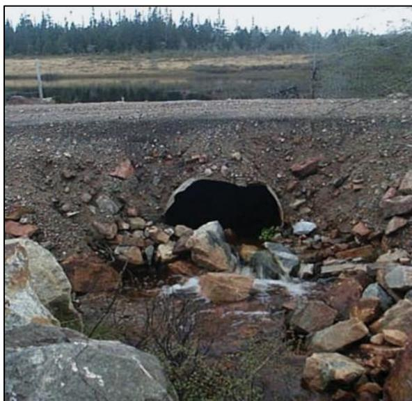
**Figure 46.** Tentative manquée de créer une marmite de géants sur un ponceau mal installé
