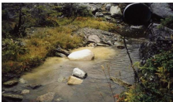
**Figure 12.** Sédiments visibles entrant dans un cours d'eau près d'un franchissement de route
