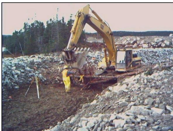
**Figure 54.** Construction de séquences de radiers et de fosses artificiels
