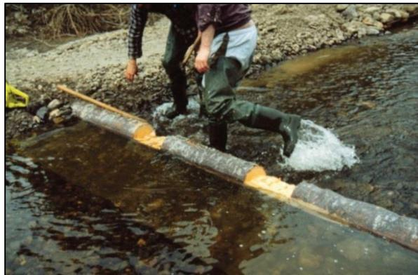
**Figure 31.** Mise en place de la poutre en travers du lit du cours d'eau
