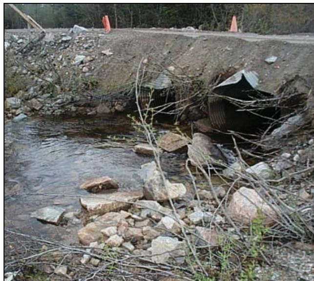
**Figure 47.** Fosse bien construite, mais mauvaise protection des berges
