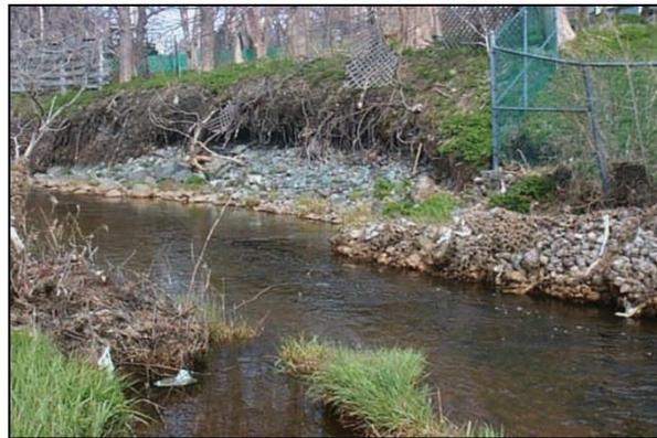
**Figure 41.** La structure en gabions effondrée a réduit la largeur du cours d'eau et a provoqué une érosion excessive directement en aval
