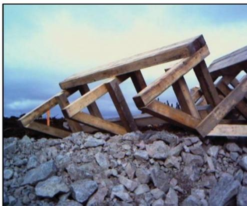
**Figure 35.** Cadre préfabriqué en bois pour le traitement des berges sous-cavées
