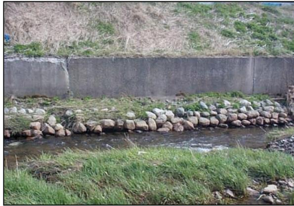
**Figure 39.** Enrochement le long d'une section de berge murée
