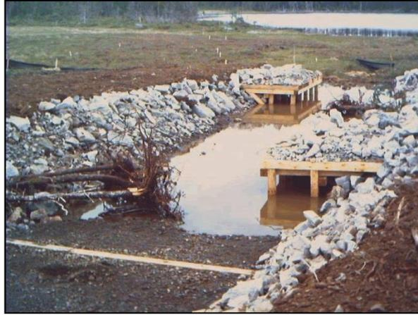
**Figure 33.** Construction d'un couvert (structures à billots sous-cavées à droite et amas de racines à gauche) dans un cours d'eau artificiel avant la remise en eau
