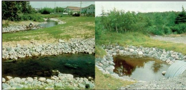
**Figure 37.** Photos de la végétation des berges (hydro-ensemencement) et de l'enrochement (à gauche), et des berges reconstruites à l'aide d'enrochement, de gazon et de végétation naturelle (à droite)
