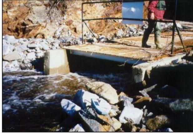
**Figure 55.** Sortie d'une passe à poissons typique à fente verticale
