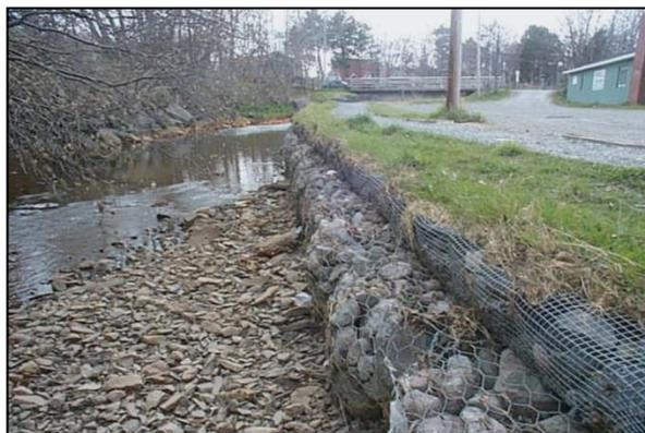
**Figure 40.** Gabion typique de berge de cours d'eau (notez le remblai et l'herbe plantée pour la stabilisation)
