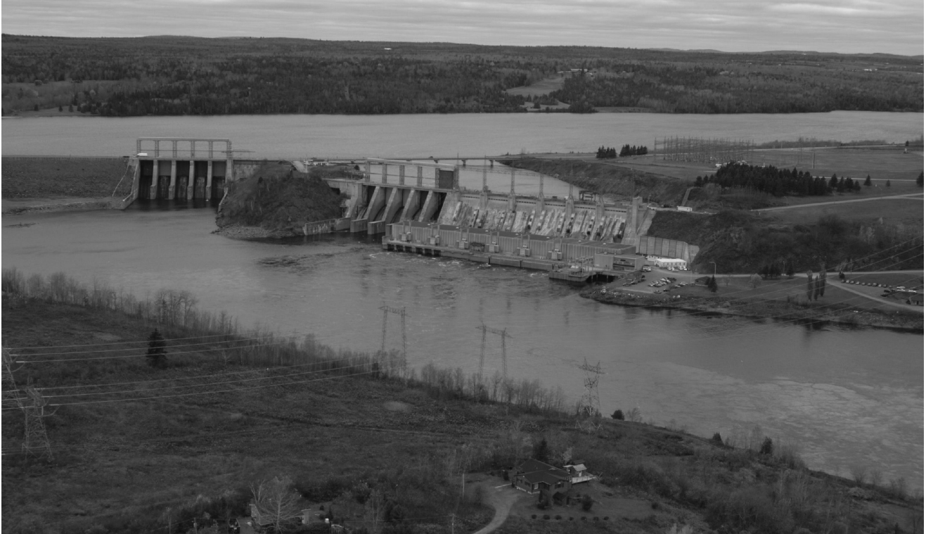
BARRAGE DE MACTAQUAC (VUE DE L'EST) (2006)
