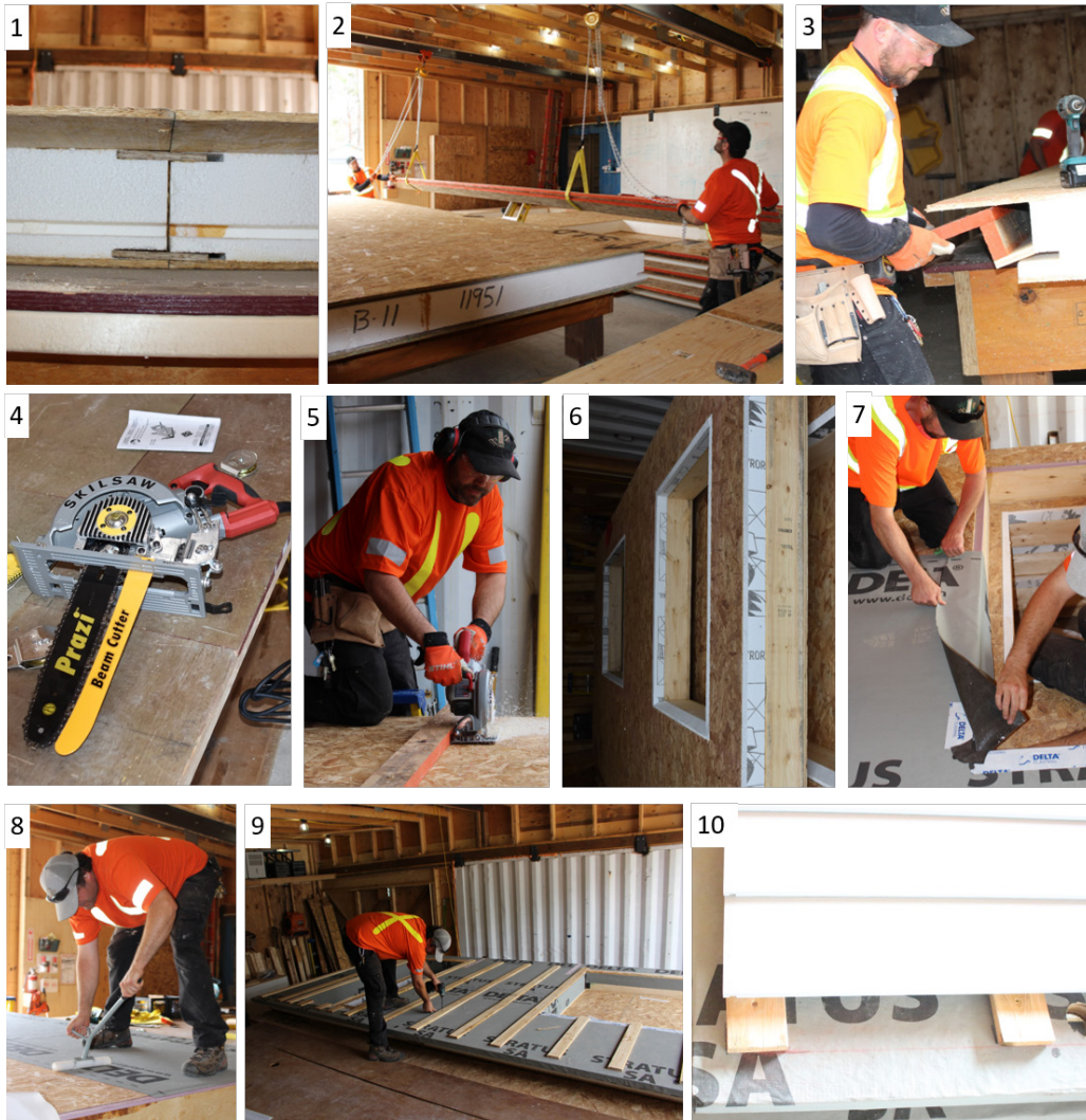
Figure 9-4: Séquence de fabrication du PIS
