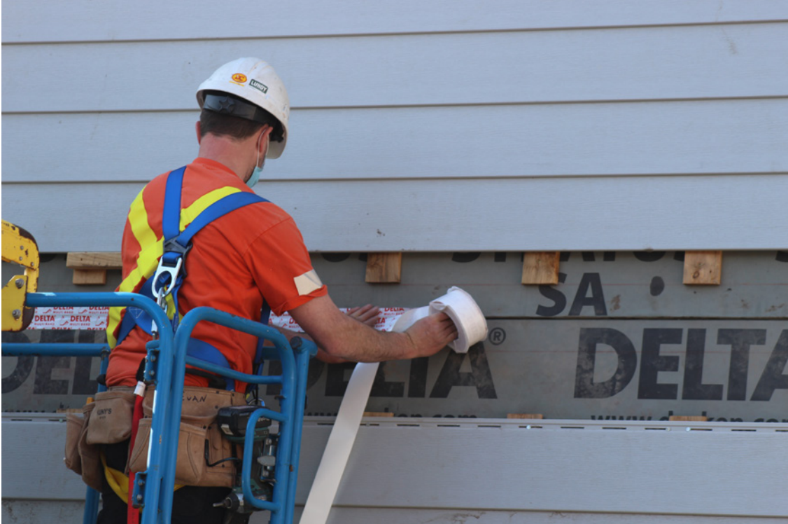
Figure 10-3 : Ruban acrylique sensible à la pression utilisée pour sceller le joint d'un panneau horizontal sur le terrain.
