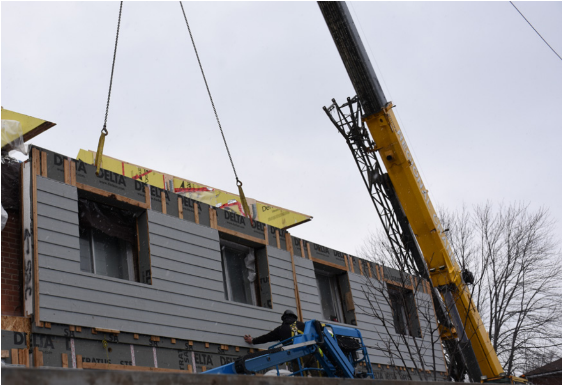
Figure 10-1 : Une grue s'est avérée plus souple et plus rapide qu'un chariot télescopique pour hisser les panneaux du Logement communautaire d'Ottawa (LCO).
