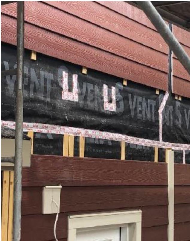
Figure 10-5 : Butterwick Projects a terminé les joints horizontaux des panneaux sur le chantier en tissant le bardage à clin à partir des panneaux supérieurs et inférieurs.
