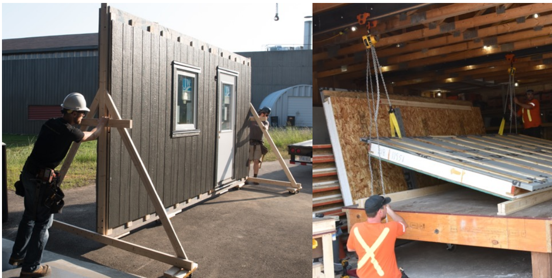
Figure 9-5 : (à gauche) Des stabilisateurs en bois sur roulettes se sont révélés être une manière abordable et efficace de déplacer les panneaux pour le projet pilote REEEP 2017. (à droite) LCO a utilisé des palans à chaîne manuels montés sur des glissières sur un rail en C en acier qui ont permis de basculer facilement les panneaux et de les déplacer à l'intérieur de l'atelier.
